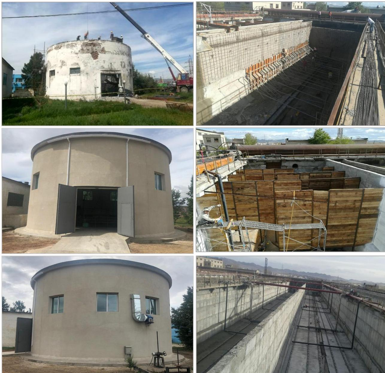
Улаанбаатар хотын төв цэвэрлэх байгууламжийн дугуй резервуарын барилгыг дотор инженерийн шугам сүлжээний хамт шинэчлэн барих болон аэротанкийн бетон хийцийн эвдрэлийг засах, цэвэрлэгээний чанарыг сайжруулах агаарын диффузер, селектор нэмж суурилуулна.
