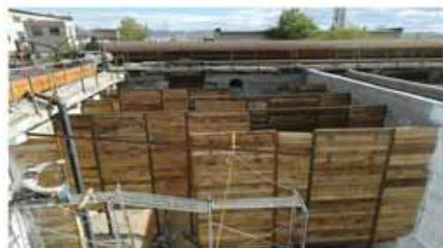
1950-иад онд баригдсан анхдагч сараалжны зориулалттай дугуй резервуарын барилгыг бүрэн буулгаж, буцааж шинээр барих угсралтын ажил бүрэн дууссан ба дотор ИШС болон дотор заслын ажлыг үргэлжлүүлэн хийж байна. Өвлийн улиралд гадаа ажиллах нөхцөлгүй болсон тул гадна фасадын ажлыг ирэх хавар хийхээр төлөвлөсөн. Дугуй резервуарын барилгыг 2019 онд аэротанк №4, №5-ын засварын ажил бүрэн дууссаны дараа байнгын ашиглалтанд хүлээлгэн өгөх юм.
