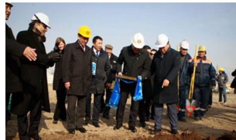
"Сэлбэ" дэд төвд 26.68Мвт хүчин чадал бүхий олон улсын стандартад нийцсэн дулааны станц, дулааны шугамыг барихаар төлөвлөн олон улсын нээлттэй тендер зарлахад "Хүрд" ХХК болон БНХАУ-ын "Шиншианг Гонгшэн Бойлер" ХХК түншлэл шалгарсан. Уг дулааны станц болон дулааны шугамын ажил хийгдсэнээр инженерийн шугамд 6,000 орчим өрхийн 25,400 иргэн хамрагдан гэр хорооллын нүүрсний хэрэглээ 15 мянган тонноор буурна.
